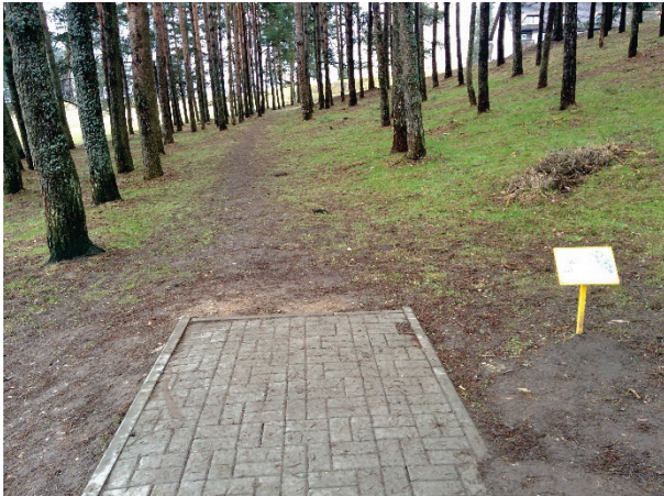
Foto 10. Betoonkivi kattega tiiala. Autor: Argo Ingver
